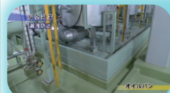
オイルパンの設置
